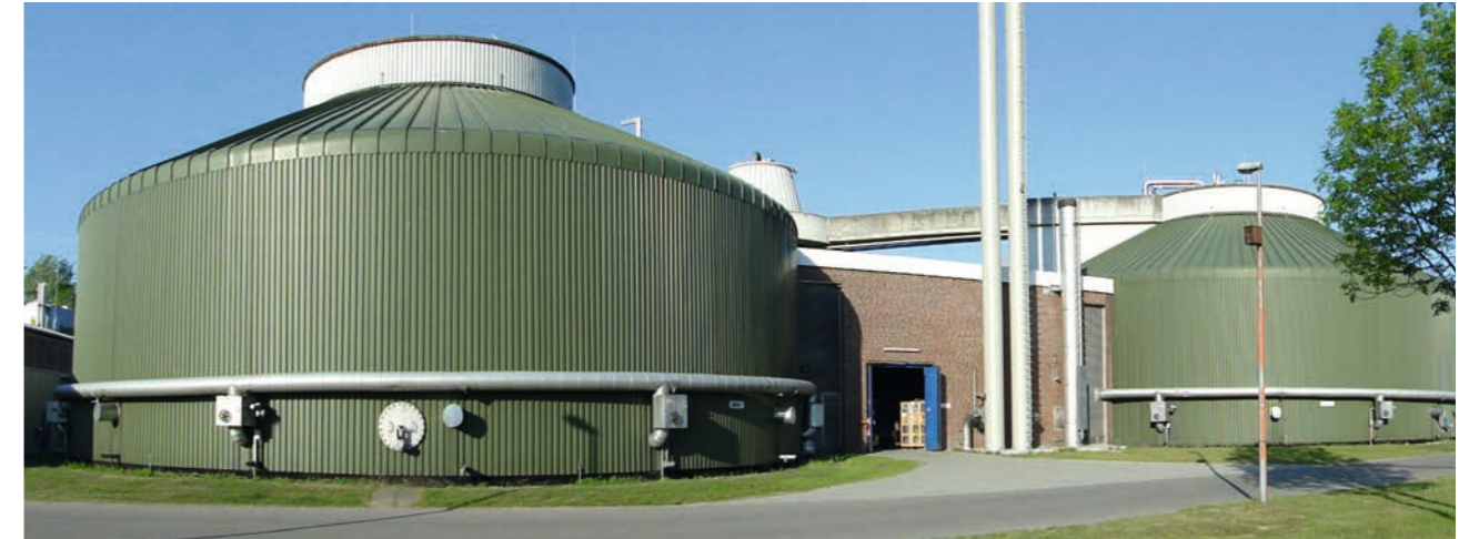
FAULBEHÄLTER DER KLÄRANLAGE HETLINGEN
