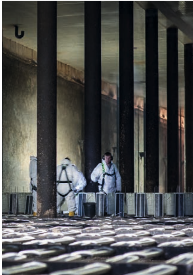
ARBEITEN IM UNTERIRDISCHEN BELEBUNGSBECKEN
