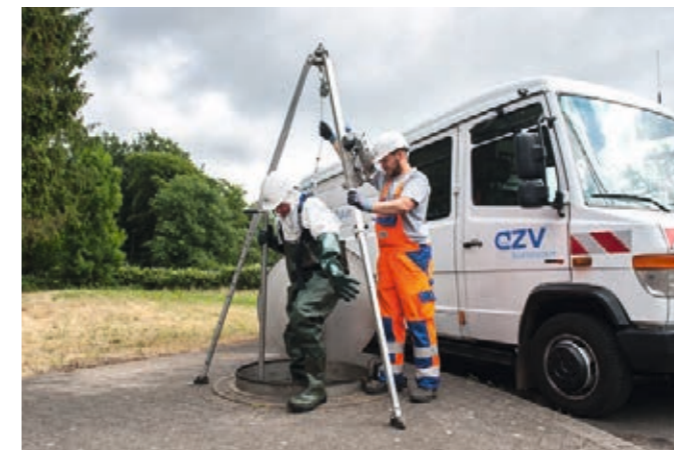
SICHERER EINSTIEG IN DEN KANAL
