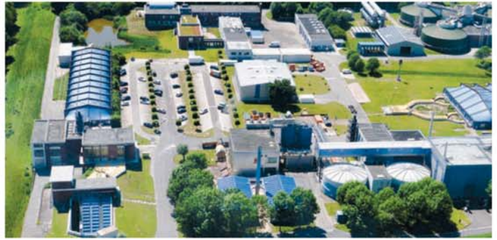
Die blauen Zelte werden verschwinden: links im Bild das Zulaufpumpwerk mit dem dahinter liegenden Rechengebäude und dem Sandfang. Ganz rechts ist ein Teil des blauen Zeltdaches der Vorklärung zu sehen. Foto: AZV
