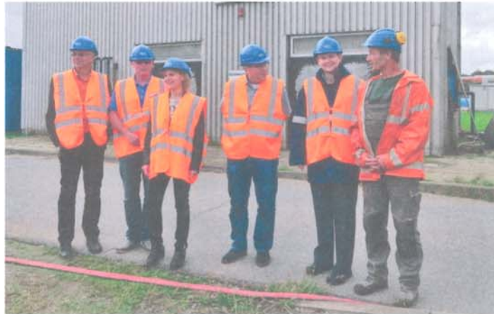
Besichtigten gemeinsam die Baustelle: Michael Rahn, Holger Martinsteg, Bürgermeisterin Monika Riekhof und Ralf Hübner aus Hetlingen, azv-Vorstand Christine Mesek und ein Mitarbeiter der mit der Sanierung beauftragten Firma (v.l.n.r.).
