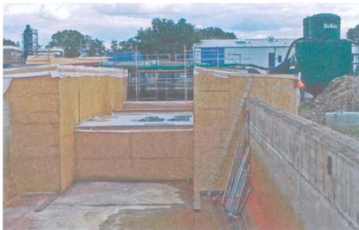
Blick ins Vorklärbecken: So sieht die Einhausung aus, in der unter Unterdruck sandgestrahlt wird.
