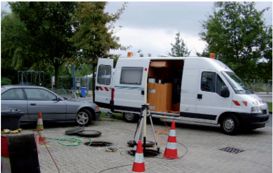
Abb. 3: Druckprüfung mit Wasser einer gewerblichen Entwässerungsanlage
