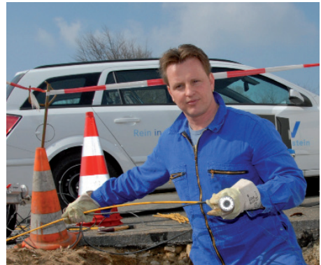
Abb. 2: Vorbereitung der Rohrleitungsinspektion mit der Kamera
